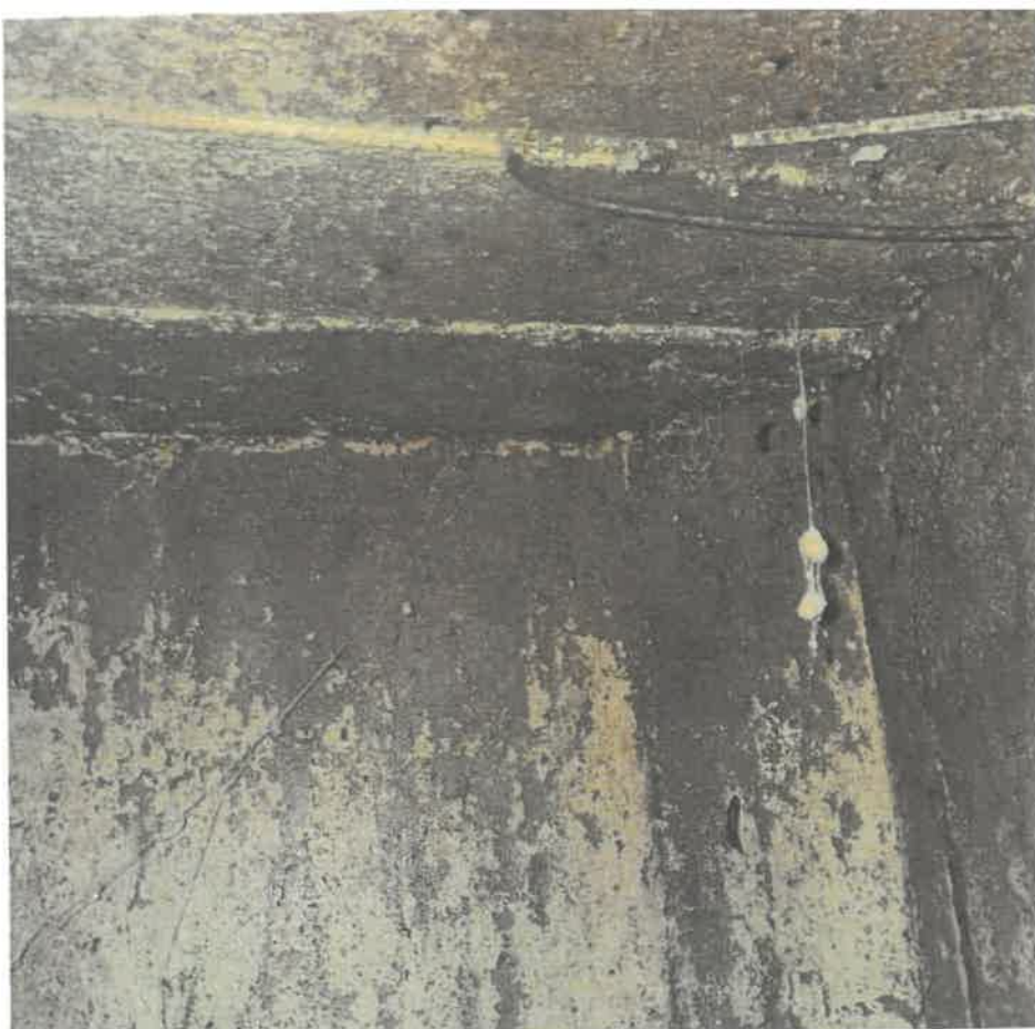
Foto nr 3. – zły stan ścian i stropu, duża wilgotność.
