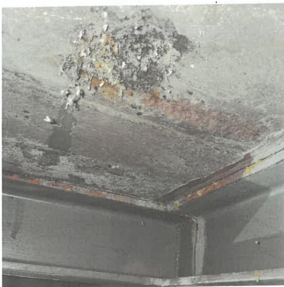
Foto nr 2. – elementy konstrukcyjne do odświeżenia oraz zniszczona powierzchnia stropu.
