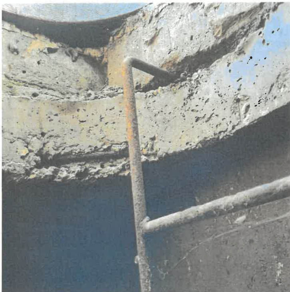
Foto nr 1. – widoczne pręty zbrojeniowe, zły stan drabinki.
