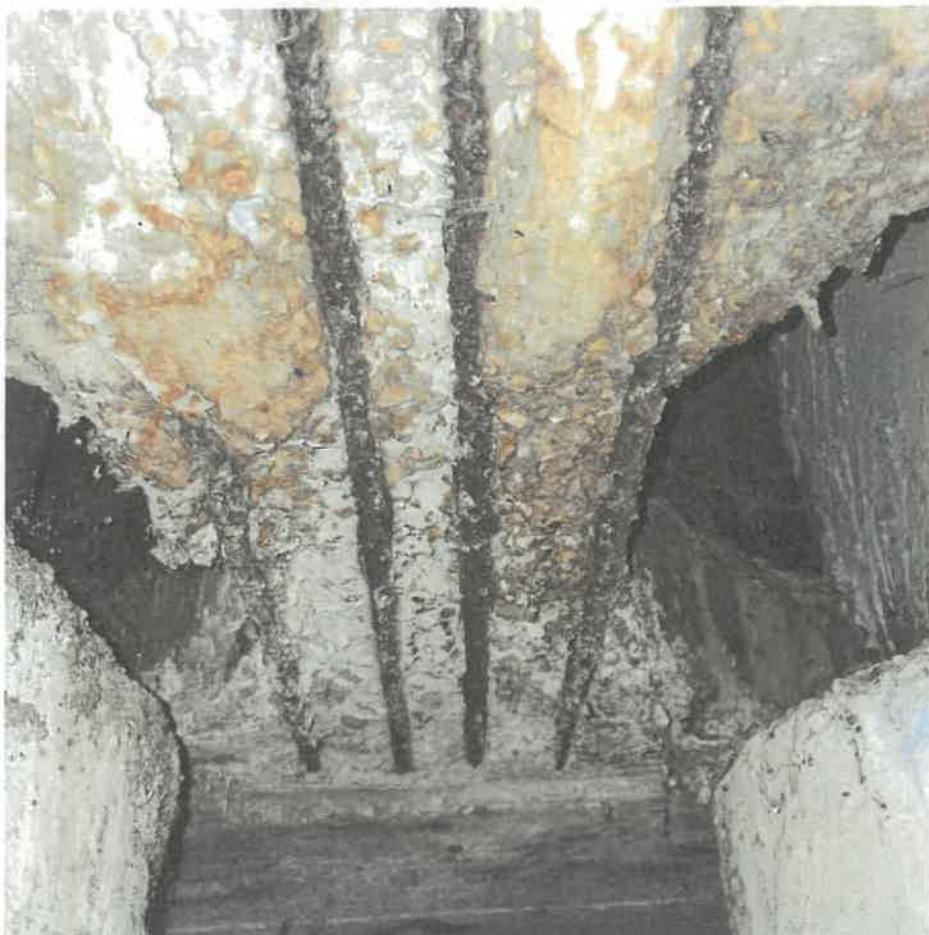
Foto nr 2. – widoczne uszkodzenia stropu, wystające pręty zbrojeniowe, fatalny stan przejść rur przez strop.
